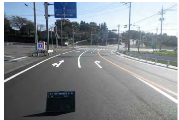
◆表彰受賞：前橋土木事務所長表彰 発注者：群馬県前橋土木事務所 工事名：社会資本総合整備（防災・安全）（交安） 主要地方道 渋川大胡線 完 成：平成29年11月完成
