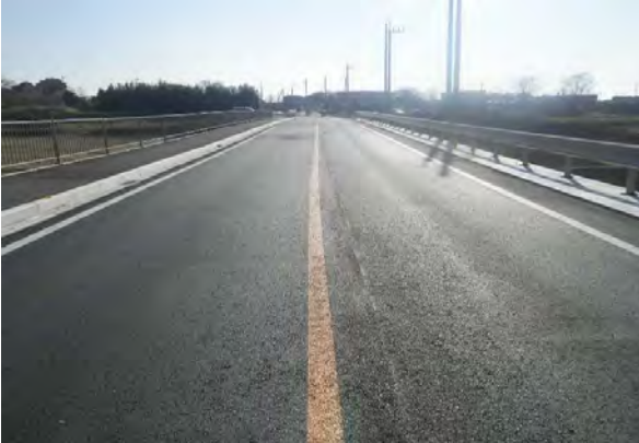
◆表彰受賞：前橋土木事務所長表彰 発注者：群馬県前橋土木事務所 工事名：単独公共 単独道路改築事業 主要地方道 前橋西久保線 完 成：平成27年12月完成
