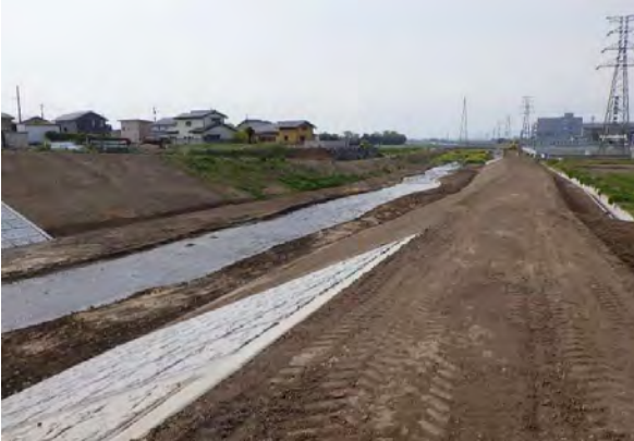
◆表彰受賞：前橋土木事務所長表彰 発注者：群馬県前橋土木事務所 工事名：社会資本総合整備（防災・安全社会資本整備交付金）（3か年）護岸工 分割2号 完成：令和2年9月完成
