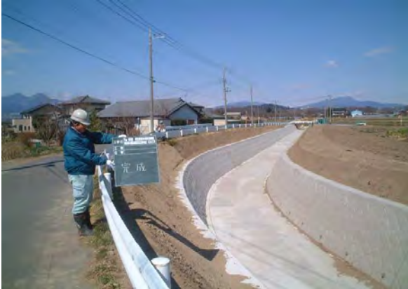
発注者：群馬県中部農業総合事務所 工事名：県営農業用水再編対策事業（地域用 水機能増進型）大正用水地区1工区 2工事 完 成：平成16年3月完成
