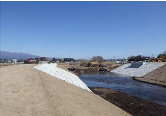
◆表彰受賞：群馬県県土整備部長表彰 発注者：群馬県前橋土木事務所 工事名：社会資本総合整備（防災・安全社会資本整備交付金）9号橋下部工 一級河川 寺沢川 完成：令和3年3月完成
