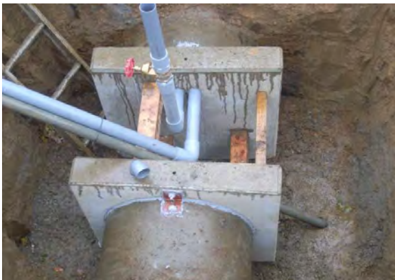
発注者：（独）水資源機構群馬用水総合事業所 工事名：群馬用水管路充てん工事 完 成：平成21年12月完成
