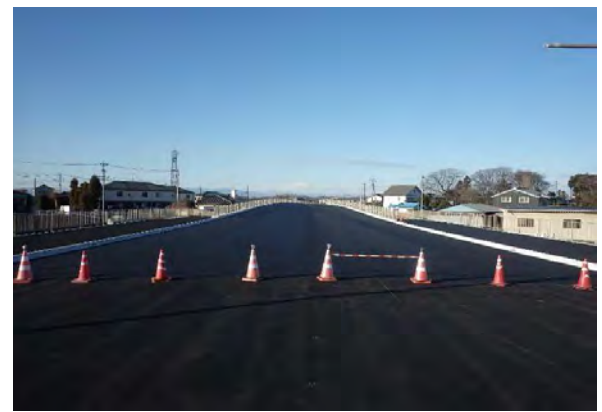
発注者：群馬県前橋土木事務所 工事名：補助公共 社会資本総合整備（活力・重 点）分割13号（舗装工その1） （一）南新井前橋線 完 成：平成29年3月完成
