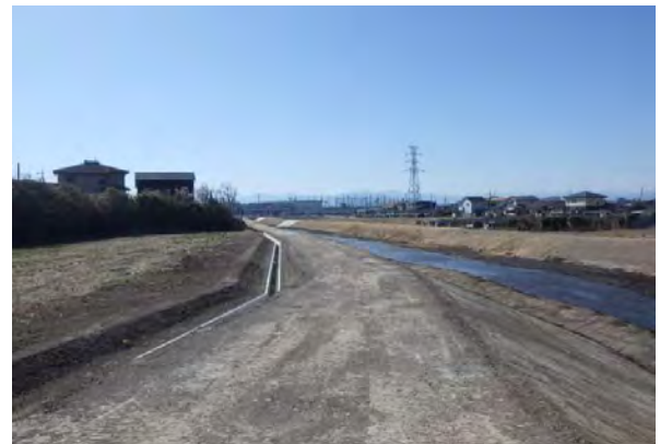
◆表彰受賞：前橋土木事務所長表彰 発注者：群馬県前橋土木事務所 工事名：社会資本総合整備（防災・安全社会資本整備交付金・補正）護岸工 一級河川寺沢川 完成：令和3年3月完成
