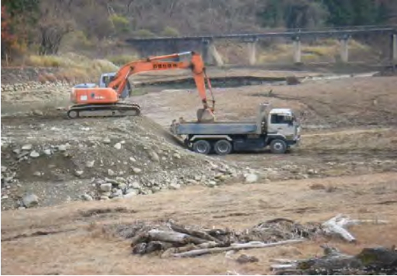
発注者：関東地方整備局利根川ダム統合管理事務所 工事名：H22相俣ダム湖中堰土砂搬出工事 完成：平成23年1月完成
