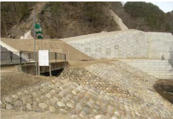
◆表彰受賞：難工事功労表彰 発注者：関東地方整備局利根川ダム統合管理事務所 工事名：R1林地区管理用道路整備外工事 完成：令和3年3月完成
