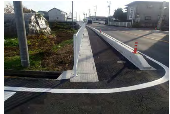
◆表彰受賞：前橋土木事務所長表彰 発注者：群馬県前橋土木事務所 工事名：単独交通安全対策事業（側溝整備） 主要地方道 前橋大間々桐生線 完成：平成27年12月完成
