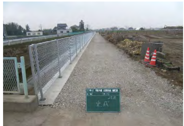
発注者：群馬県中部農業事務所発注 工事名：大正用水地区 補完工事 完 成：平成22年3月完成
